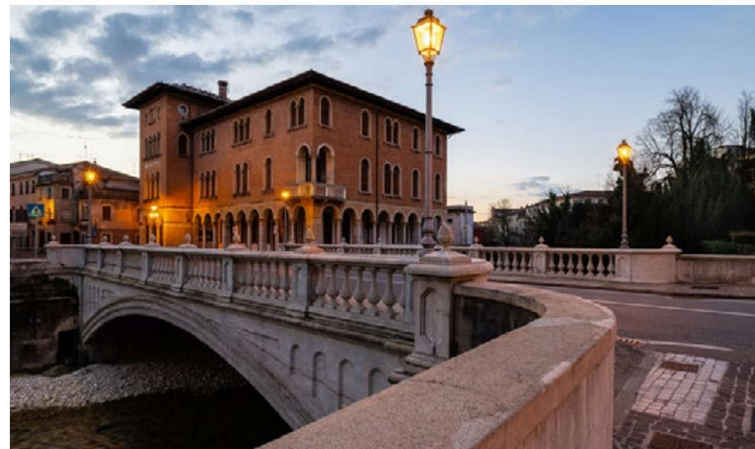
PONTE CONSENZIOSO - PIEVE DI SOLIGO
