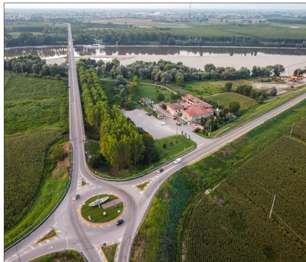
Ponte Boretto - Viadana
